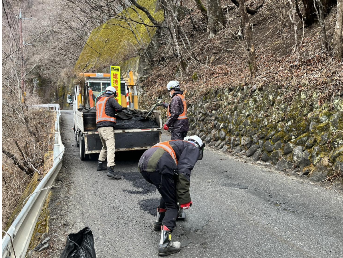
維持作業班の運営
