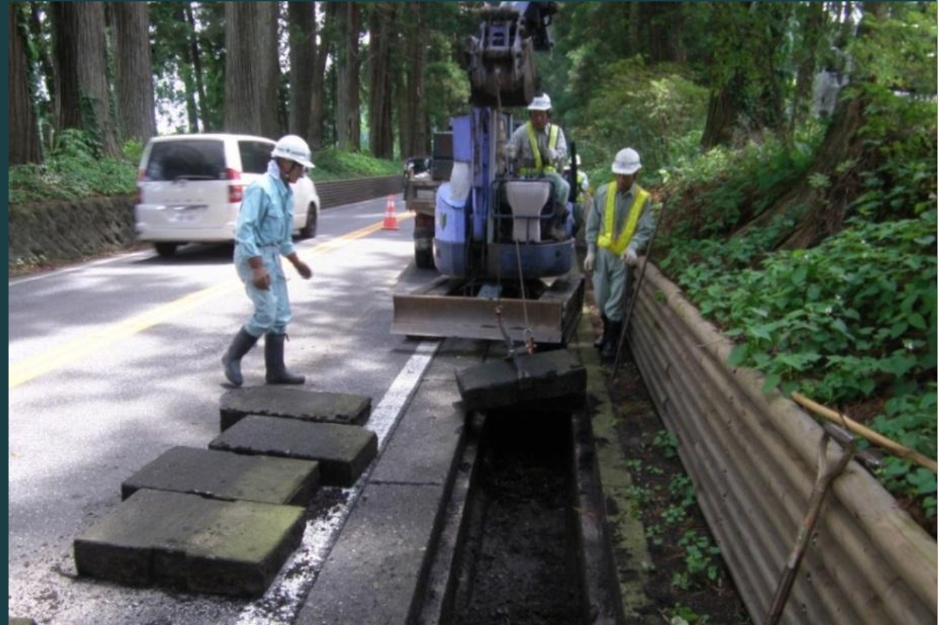
維持工事(側溝清掃)
