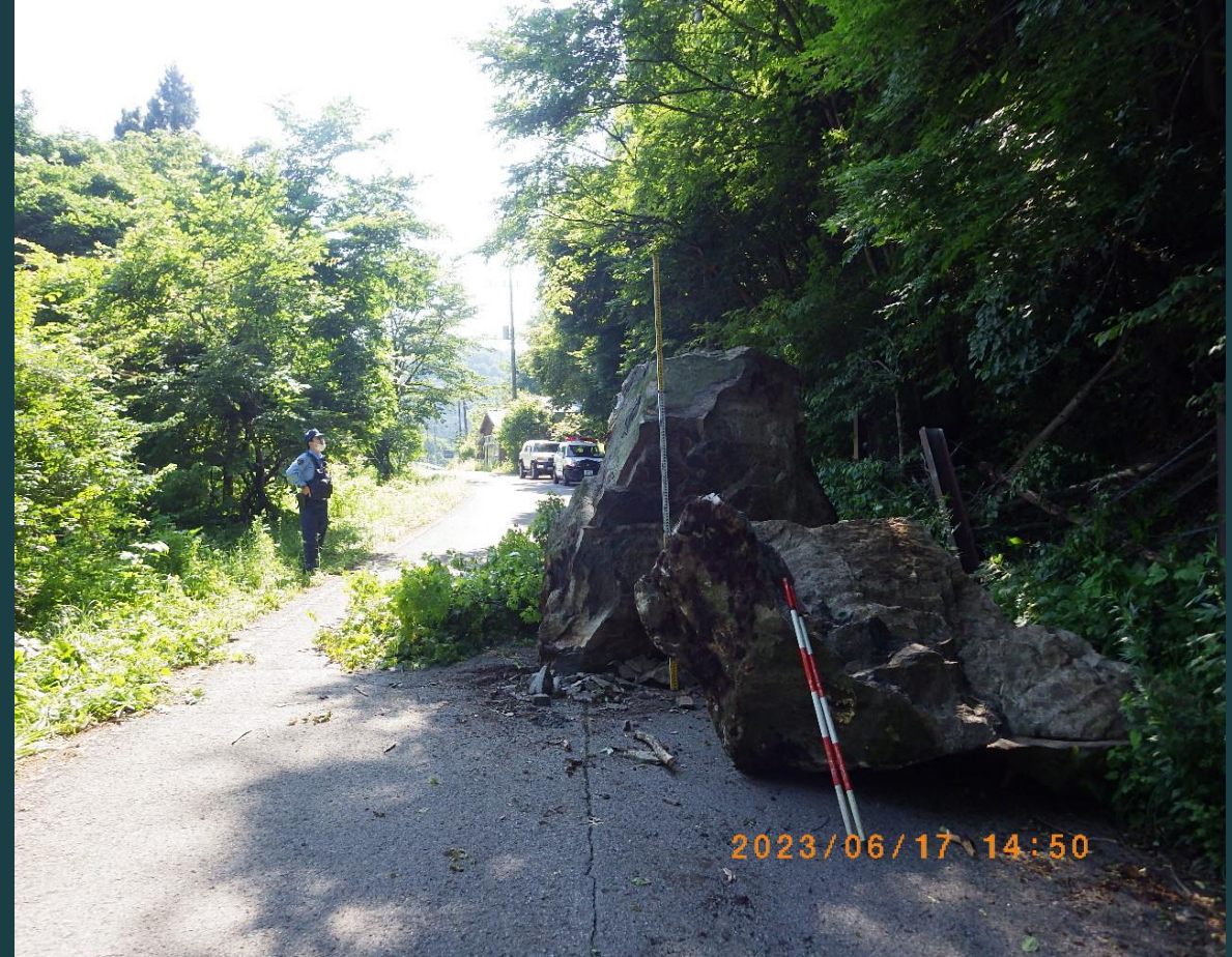
県道 黒部西川線 落石処理
