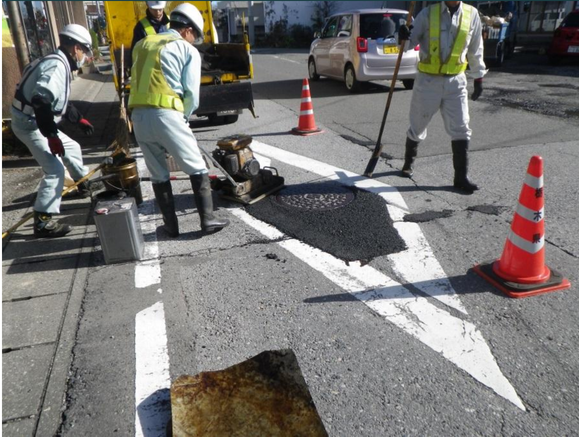
維持工事(舗装修繕)
